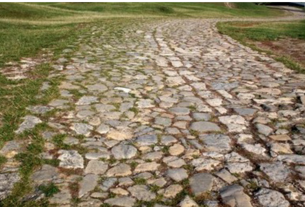
přechod dlažby do trávy
